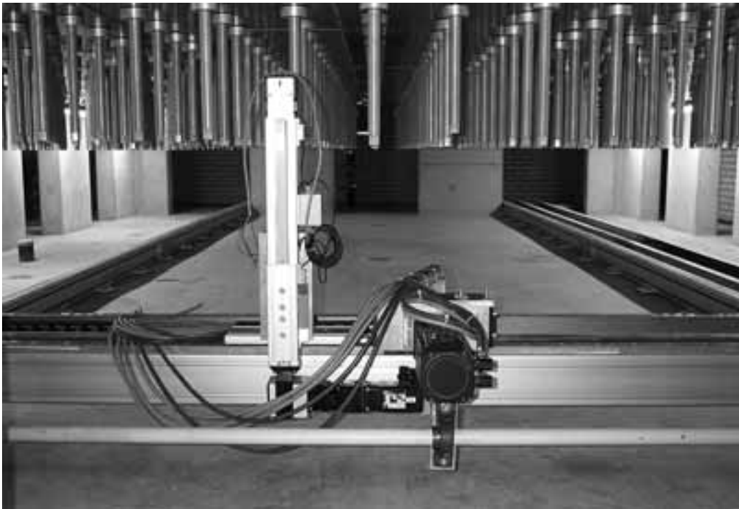
De onderkant van de Eurotank. Iedere staaf is verbonden met een stuk bodem dat onafhankelijk hoger en lager gesteld worden.
