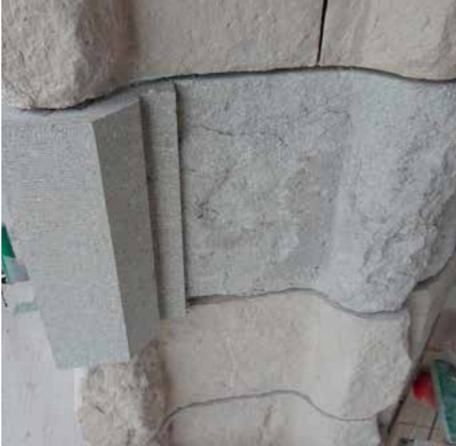
Monte Merlo (links) naast Drachenfels trachiet (rechts), met daaronder en -boven Ledesteen aan de Domtoren.
