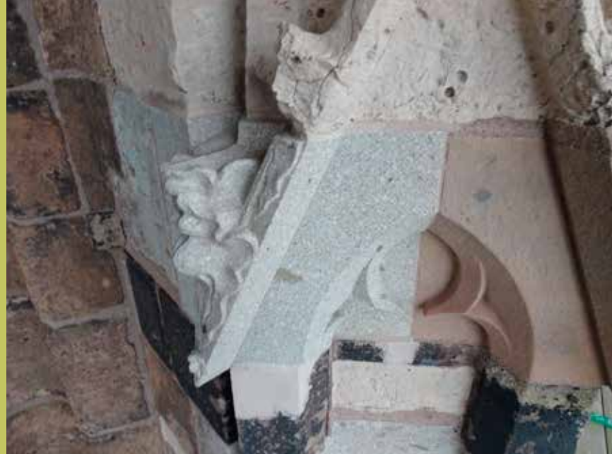
Nieuwe deel van een wimberg (steil, driehoekig gevelement boven vensters en portalen) van de Domtoren in Monte Merlo (links); daarnaast Udelfanger zandsteen; daarboven Ledesteen.
