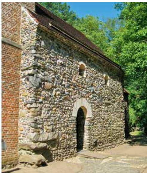
11e-eeuws zaalkerkje van Erpekom (nu in het Openluchtmuseum van Bokrijk, Genk) volledig opgebouwd in Maaskeien. Foto: Roland Dreesen.
