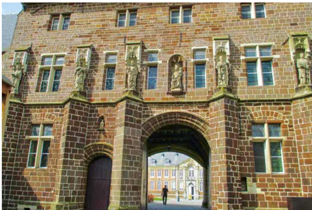
Ingang van de abdij van Averbode, opgetrokken in lokale ijzerzandsteen. Foto: Roland Dreesen.
