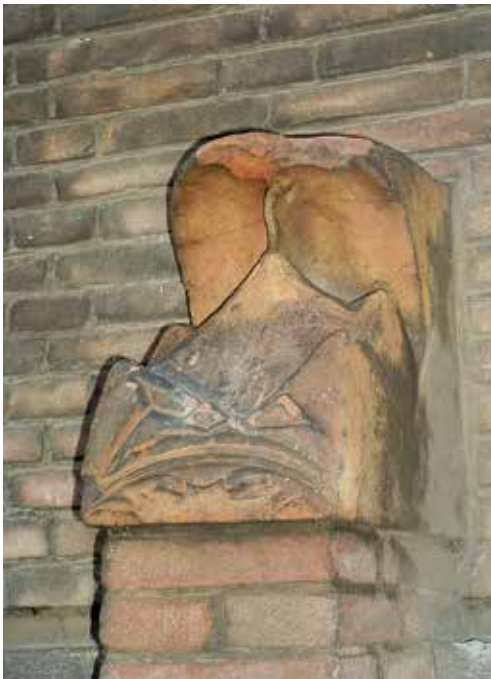
Pijlerbekroning aan de gevel: Vulkaan. Geplaatst boven magmakamer.
