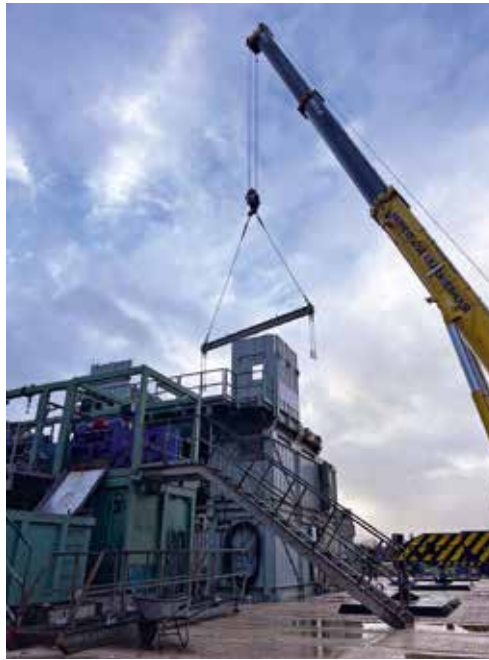
De boortoren wordt opgebouwd.
